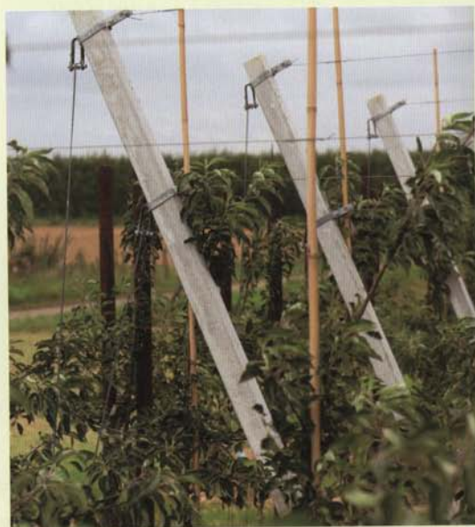
Fot. 10. Większą stabilność konstrukcji zapewnia stabilizacja skrajnych słupów z użyciem kotew – tu słup z kotwą połączono za pomocą dwóch odcinków
