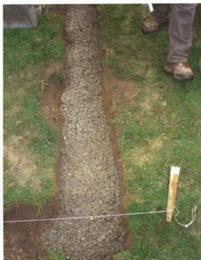
Przed umieszczeniem w ziemi płyt krawężnikowych należy ułożyć warstwę chudego betonu
