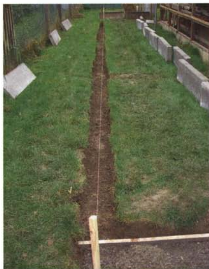
Równy naciągnięty sznurek pozwoli wykonać prosty wykop pod fundament
