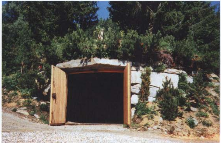
Piwnica w skale na Krameterhofie
