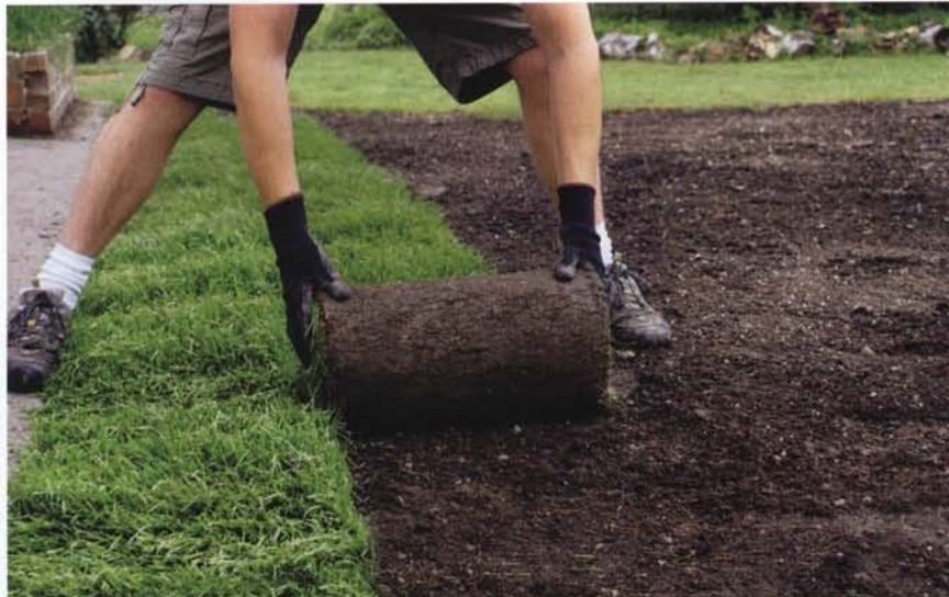
Pasy trawy układa się, dokładnie dociskając płyty do siebie i do podłoża.
