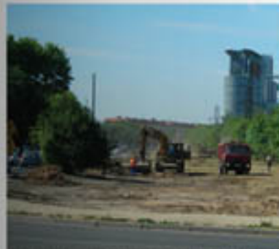
Fot. 25. Równomierne użytkowanie terenu na całej szerokości, wykonywane pod budowę dwusłupowej ulicy – bez względu na planowaną lokalizację poszczególnych elementów układu drogowego (w chwili rozpoczęcia robót, ul. Bułgarska, Poznań)
