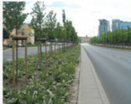
Fot. 26. To samo miejsce w części wybudowanej ulicy i po wykonaniu obsadzeń w podłożu dowiezione z zewnątrz
